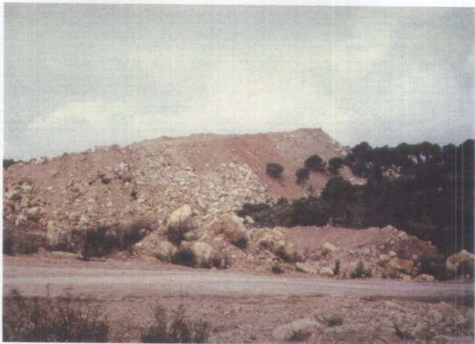
Escombrera tipo exenta ubicada en la cima de Monte Coto (vertiente Norte).
