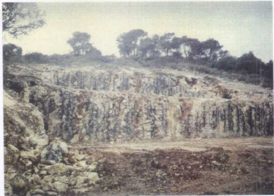
La elevada alteración y fracturación de la roca y la presencia de materiales arcillosos facilitan las actuaciones de restauración de canteras sin posibilidades de explotación.
